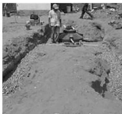
Zanja de infiltración
