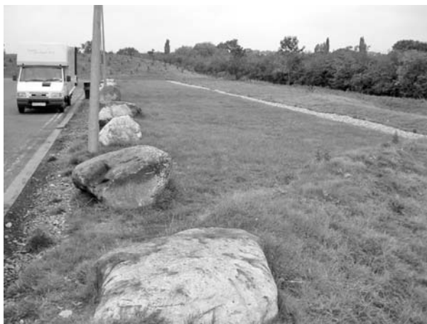
Figura 6 – Faixa filtrante contígua a uma rodovia. Fonte: Internet. 19
