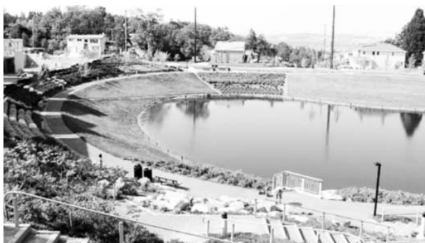
Figura 14 – Lagoa de retenção. Fonte: Internet. 29
