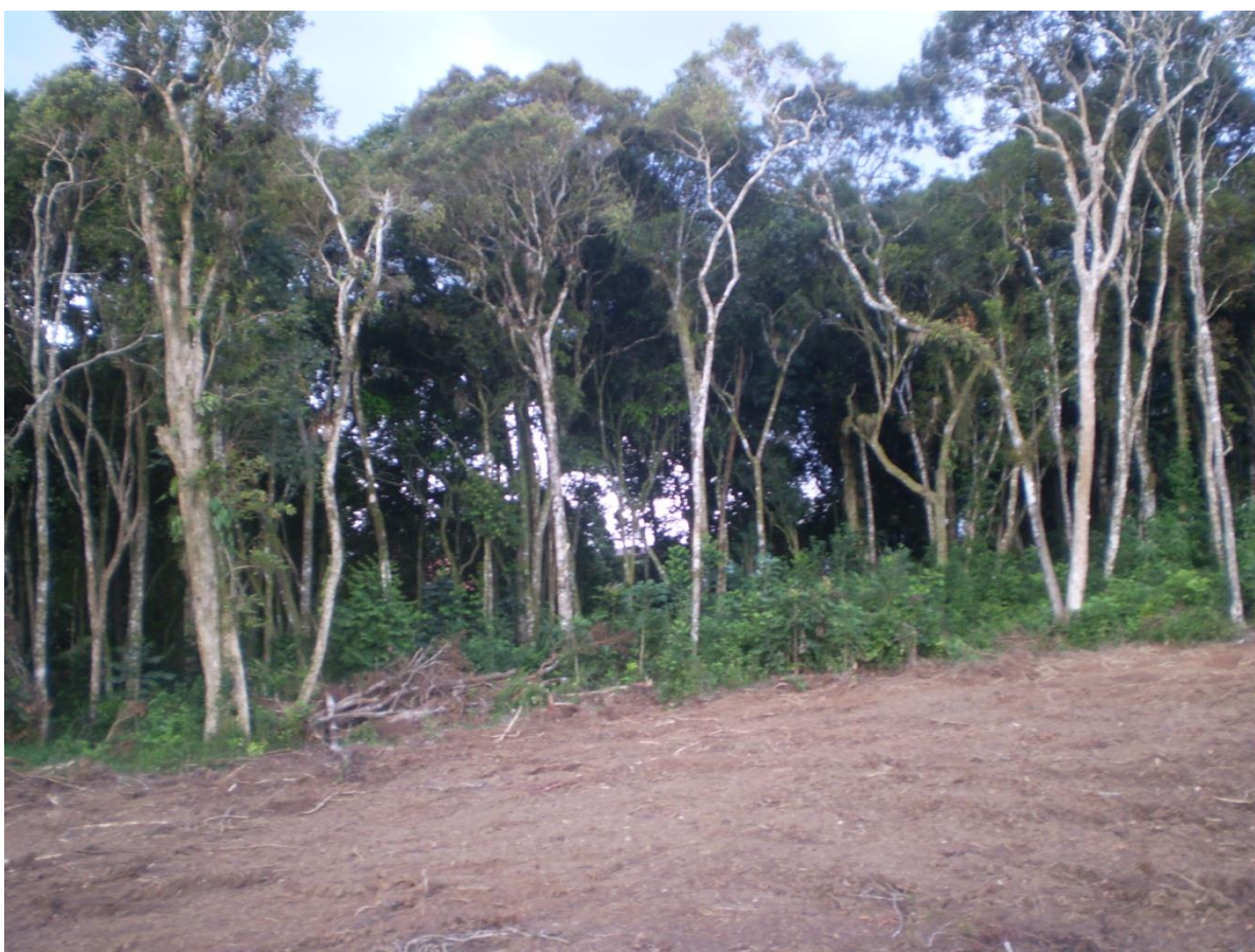
Fotografia/Imagem 04: corte raso de vegetação nativa, em área urbana no município de Tijucas do Sul, coordenadas 22j 0682345 utm 7132115
